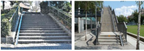
Figure 168. Exemples de traitement de la liaison verticale au niveau de l'ouvrage TCSP – escaliers équipés de rampes à vélo (Michel Desvignes Paysage, 2017)
